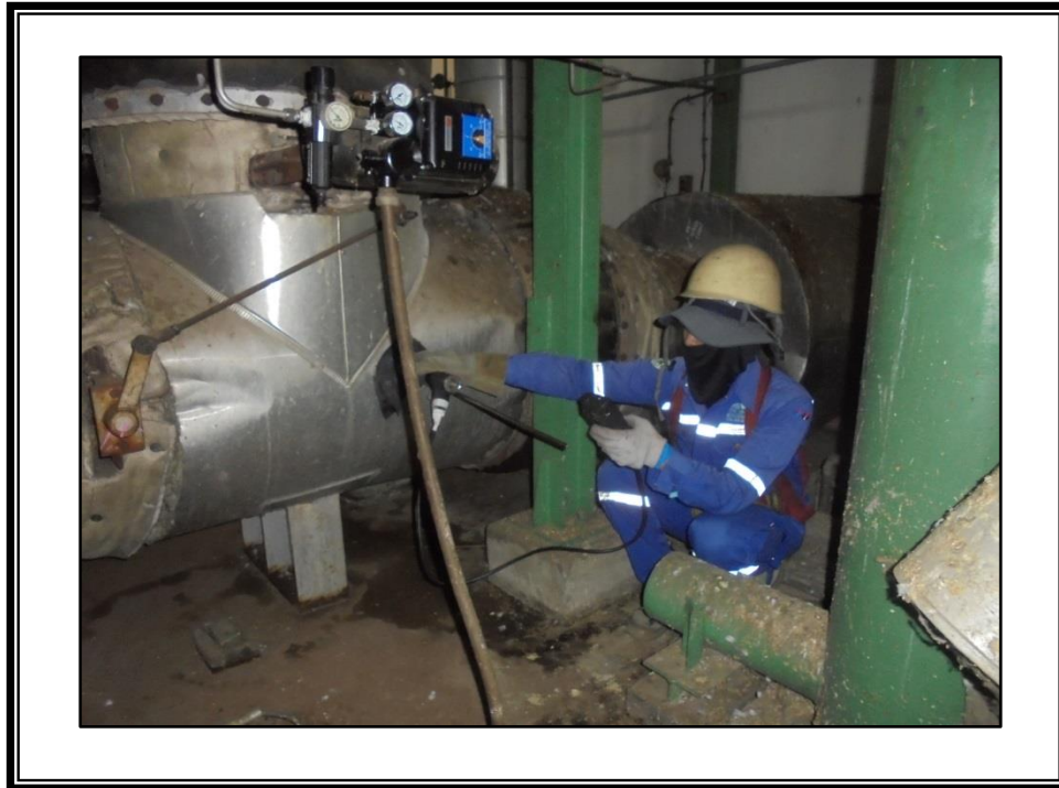
รูปที่ 3.2-1 จุดตรวจวัดคุณภาพอากาศจากปล่องปล่อยทิ้งอากาศเสีย บริเวณปล่อง Waste Heat Boiler ที่ต่อกับเครื่องยนต์ Caterpillar No.5 ในวันที่ 24 ตุลาคม พ.ศ. 2567
